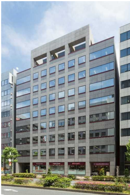
【NMF 茅場町ビル】（東京都中央区新川一丁目）
