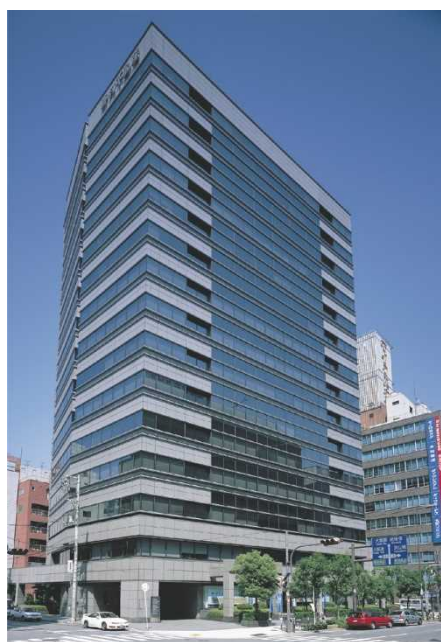
【野村不動産四ツ橋ビル】（大阪府大阪市西区阿波座一丁目）
