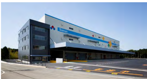
沼津物流センター（静岡県沼津市足高）
