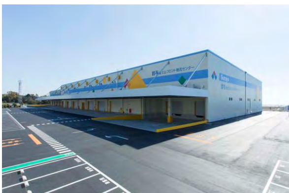
富士山フロント物流センター（静岡県富士市大淵字城山）
